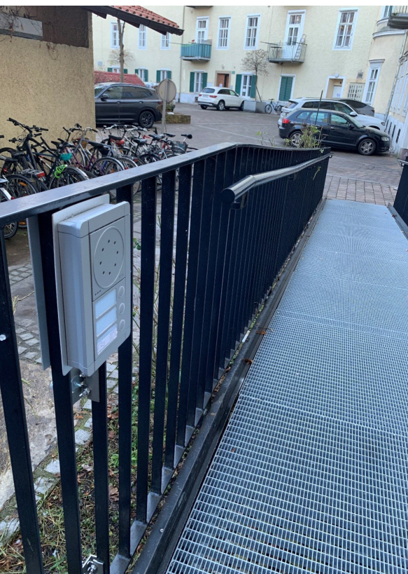
Außenstelle Graz: Barrierefrei erreichbare Gegensprechanlage an der Zugangsrampe
